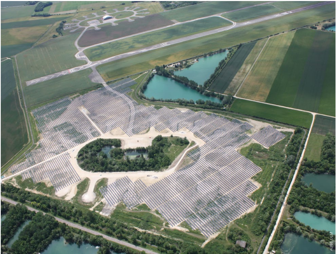
Centrale photovoltaïque de Lassicourt (Aube).
