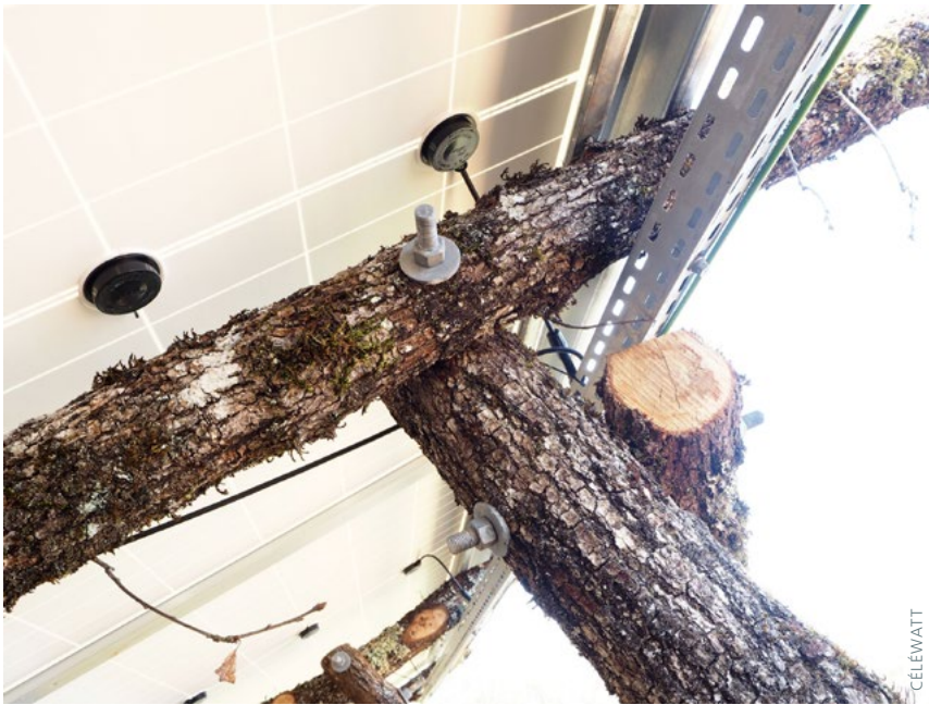
^ Gros plan sur un pieu en chêne de Causse servant de structure pour les panneaux du parc de Carayac.
